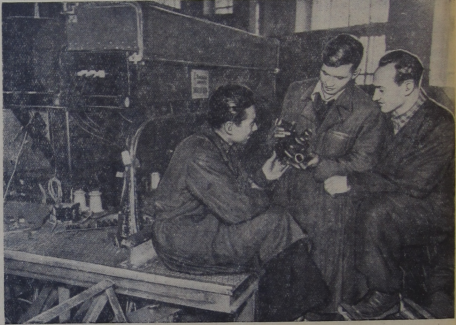
На снимке: группа сотрудников Лаборатории высоких энергий за монтажом двухметровой диффузионной камеры, предназначенной для регистрации ядерных процессов, происходящих при больших энергиях. Слева направо: инженер Ю. Д. Зернин, младший научный сотрудник В. И. Мороз и инженер А. М. Гальпер.
