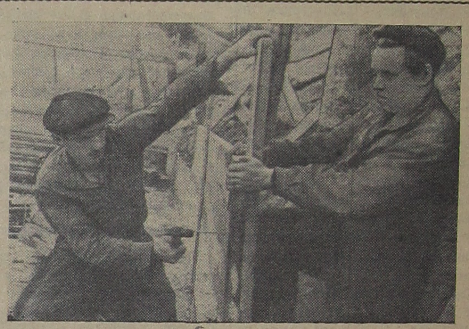
В коллективе 1-го строительного участка по праву лучшими плотниками считаются В. Новиков и П. Самойлов. Они выполняют нормы на 200 процентов. На снимке: В. Новиков и П. Самойлов за установкой опалубки под фундамент нового здания. Фото Н. Печенова.
