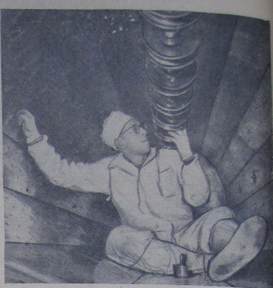
Установка труб дрейфа линейного ускорителя в Лаборатории высоких энергий. Работу проводит старший техник Ю. В. Простякин. Фото В. Шустина.
