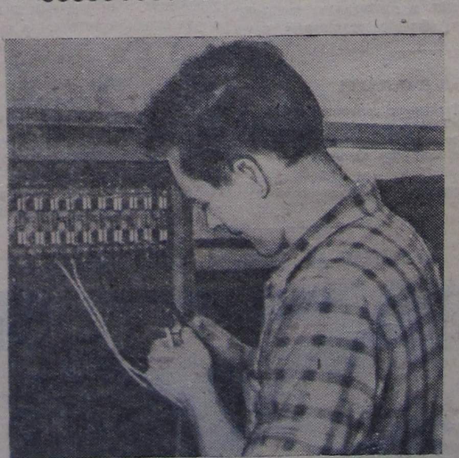
В Дубненской городской конторе связи производится монтаж радиотрансляционного узла. Теперь радиотрансляционный узел может обслуживать гг. Дубну и Иваньково. На снимке: техник-монтажник Владимир Титов за монтажом стойки радиоузла. Фото А. Тиховой.
