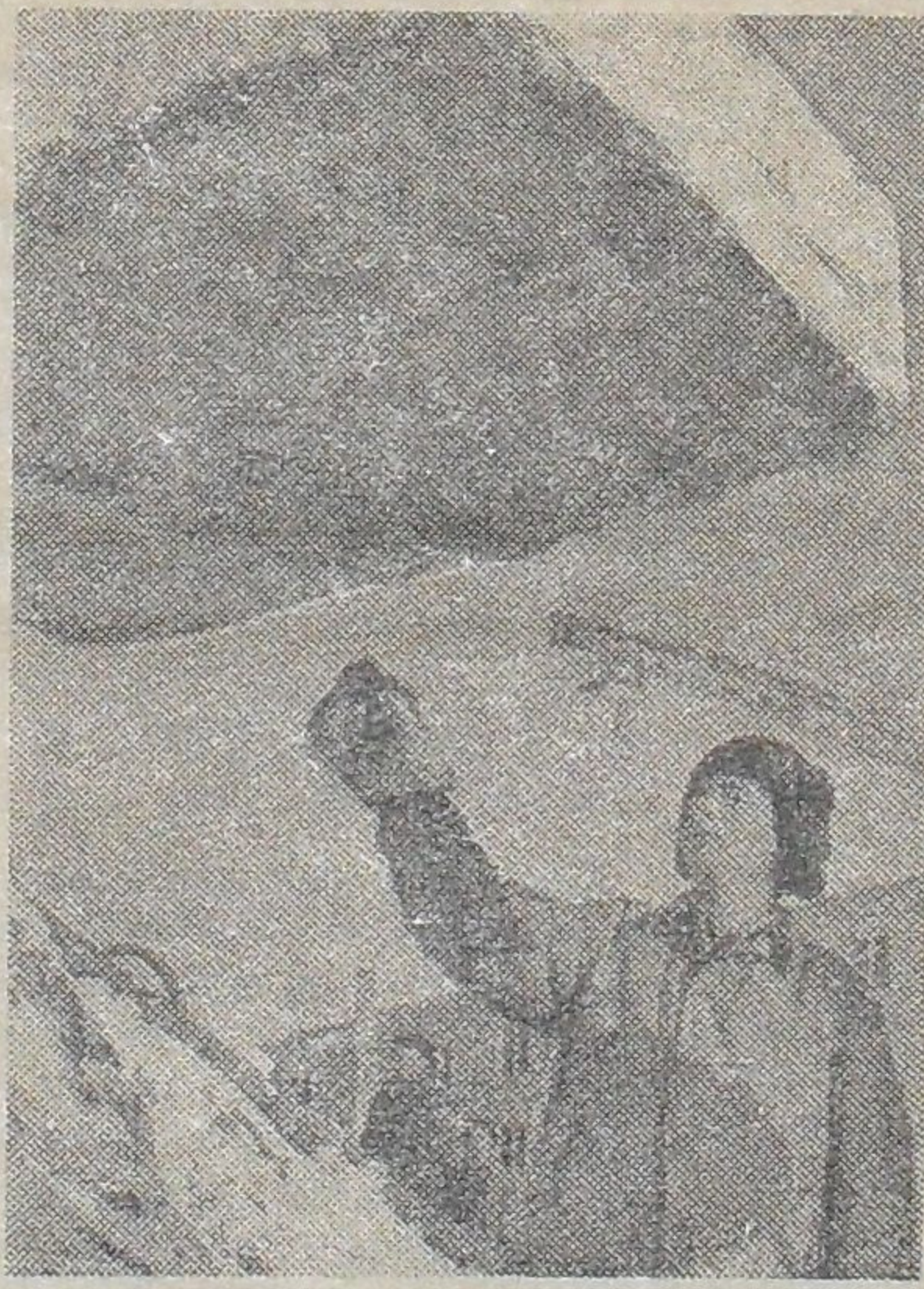
Когда началось строительство нового жилого квартала на Большой Волге, из бригады каменщиков коммунистического труда А. Цветкова на освоение метода монтажа жилых домов из крупных панелей, были направлены два лучших каменщика Сергей Перфильев и Иван Забебин. На снимке: каменщик-монтажник Иван ЗАБЕБИН укладывает фундаментные подушки в котлован нового дома.
