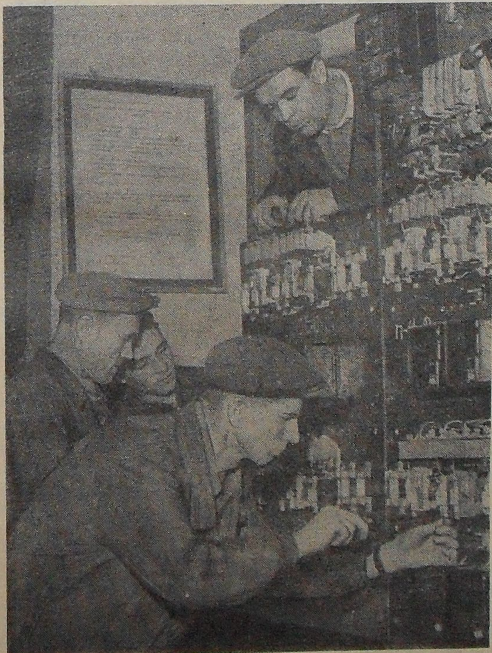
Хорошо поработала на монтаже щитов управления для новой физической аппаратуры группа электромонтажников отдела главного энергетика и слесарей из эксплуатационных мастерских Лаборатории высоких энергий. Весь объем работ выполнен на несколько дней раньше срока. На снимке (слева направо): слесарь Д. РУМЯНЦЕВ, электромонтажник В. ЕВСТИГНЕЕВ, слесарь А. ХВОСТОВ, электромонтажник Г. РОМАНОВ за монтажом щита. Фото В. Шустина.
