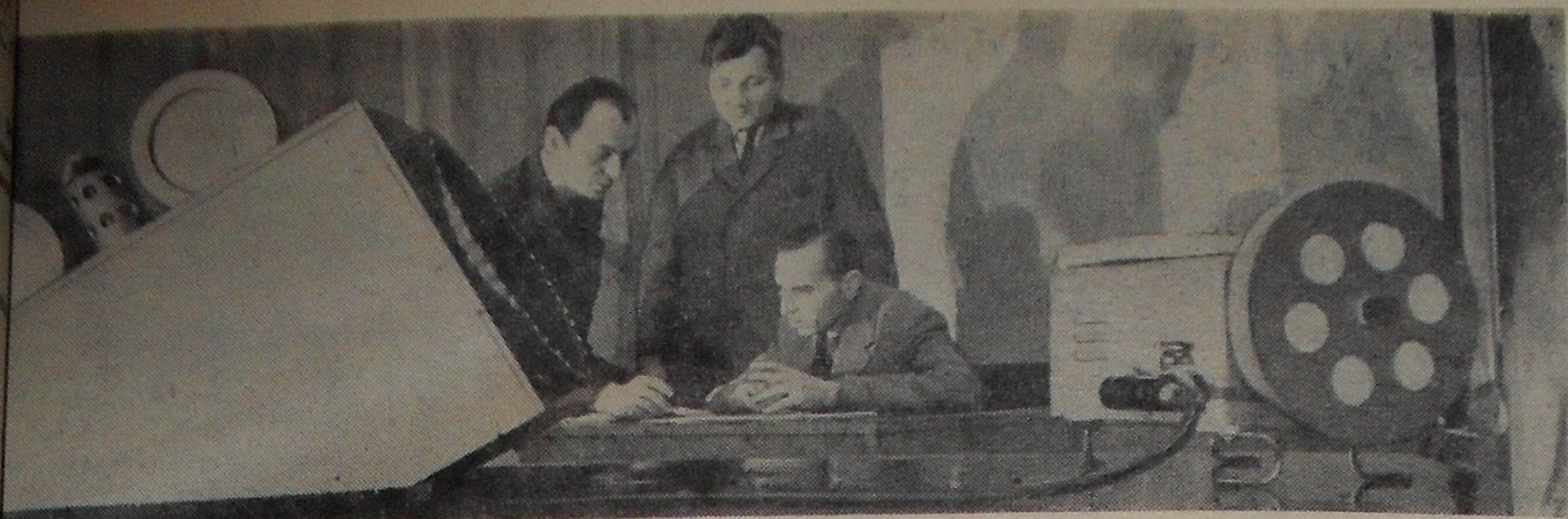
В Лаборатории ядерных проблем группа чехословацких научных сотрудников — Мирослава Малы, Олдржих Сгон и Франтишек Легар создали новый полуавтоматический прибор для обработки фотографий с искровых камер. Он прост в управлении, позволяет увеличить скорость просмотра снимков в 5—6 раз. Данные от полуавтомата направляются прямо на счетные машины. На снимке: (слева направо) чехословацкие научные сотрудники Мирослав МАЛЫ, Франтишек ЛЕГАР и Олдржих СГОН. Фото Ю. Туманова.
