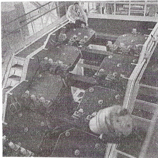
Коллектив Центральных экспериментальных мастерских внес большой вклад в сооружение отдельных узлов установки МИС ОИЯИ. На снимке: монтаж оптической системы магнитного искрового спектрометра. Фото Ю. Туманова.
