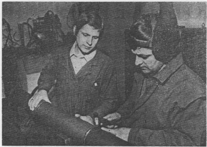
Активное участие во всех работах отдела принимают сотрудники отделения опытно-экспериментального производства. Слесарь Г. С. Мельников и сварщик И. А. Судаков ведут монтаж центрального патрубна тонколистовой камеры из нержавеющей стали. Фото В. БЕЛЯНИНА.
