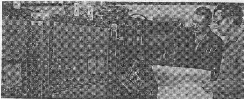
Монтаж оборудования на малярном участке ведут электрик А. И. Рачков и шеф-монтер из ЧССР А. Врана.
