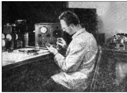
Научный сотрудник ЛЯП Ю. Н. Денисов за настройкой аппаратуры для измерения напряженности магнитного поля.
