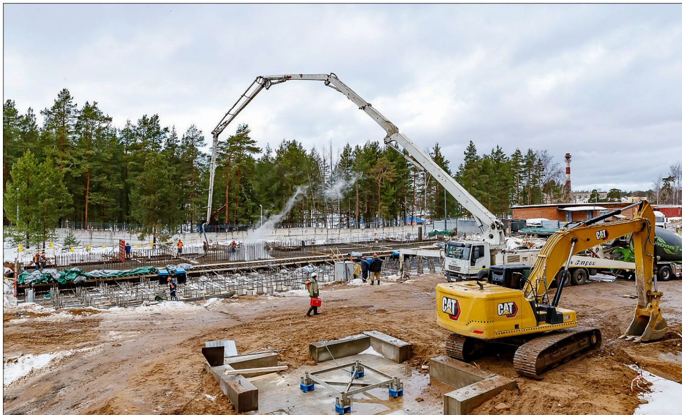
Заливка первых кубометров бетона в фундамент экспериментального корпуса У-400Р
